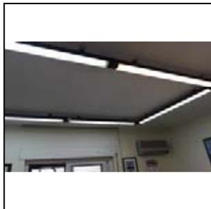
apparecchio di illuminazione costituito da struttura sospesa di circa ml 9 completo di neon
